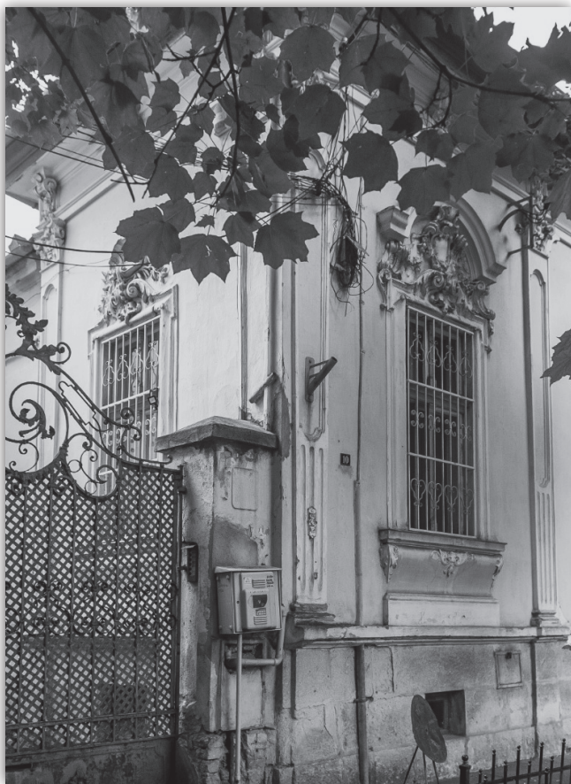
A Petelei-Czakó ház Casa Petelei-Czakó The Petelei-Czakó house (Lázár Buki)
